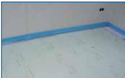
2. An allen aufsteigenden Bauteilen ist der mitgelieferte Randdämmstreifen anzubringen.
