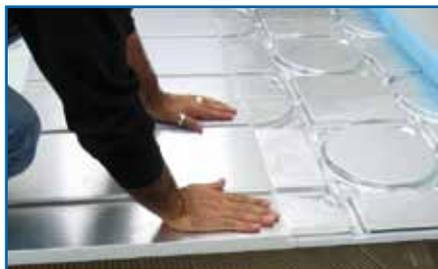
4. Umlenkelemente, gerade Elemente und Randausbauplatten entsprechend den Vorgaben des Verlegeplans in den frischen Kleber einlegen und andrücken.
