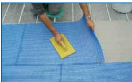
8. Die Belagträger- und Entkopplungsmatte vollflächig in den klebefreien Spezialkleber Blanke•GLUEMAX mit dem Spezialvlies nach unten (weiße Seite) einlegen und mit Hilfe eines Reibbretts bzw. einer Andruckwalze andrücken. Die Matten müssen mind. 10 cm versetzt werden. Bitte beachten Sie auch die Verlegeanleitung Blanke•PERMAT.
