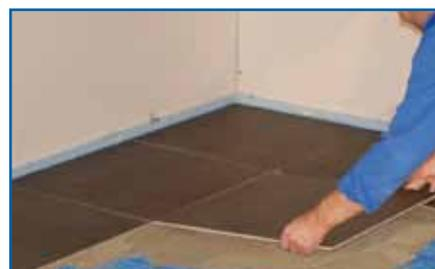
9. Der Oberbelag kann nach einer Wartezeit von 12 Std. entsprechend den geltenden Regeln im Dünnbettverfahren mit geeigneten Flexklebern verlegt werden. Bewegungs- und Feldbegrenzungsfugen sind nach den geltenden Regelwerken anzulegen. Die Inbetriebnahme des Heizungssystem kann 24 Stunden nach kompletter Fertigstellung des Belages erfolgen.
