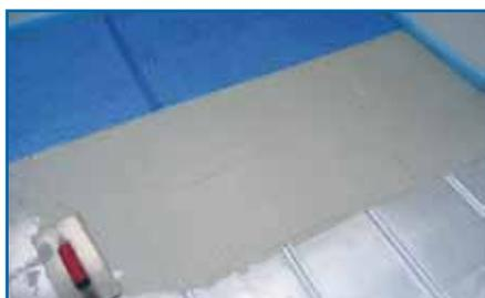
7. Nach Verlegung der Verrohrung wird der Spezialkleber Blanke•GLUEMAX mit einer 6er Zahnung auf das Aluminiumwärmeleitblech aufgekämmt. Vertiefungen der Umlenkelemente werden mit dem Verlegewerkstoff gefüllt und abgekämmt.
