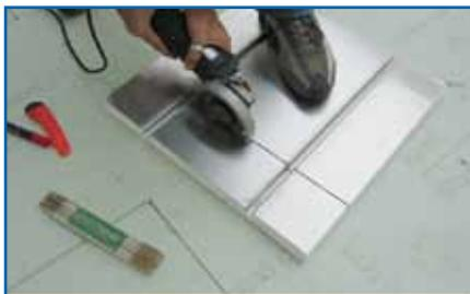
5. Der Zuschnitt der Elemente erfolgt mit dem Winkelschleifer, bestückt mit einem Metallblatt.
