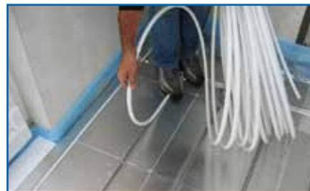
6. Nach Erhärtung des Verlegemörtels wird das Metallverbundrohr in die Omegarillen mit Hilfe des Eindrückholzes eingedrückt.
